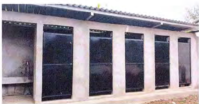
Foto 5: Baños terminados con puertas, tazas sanitarias, repellido, techado y agua instalada.
