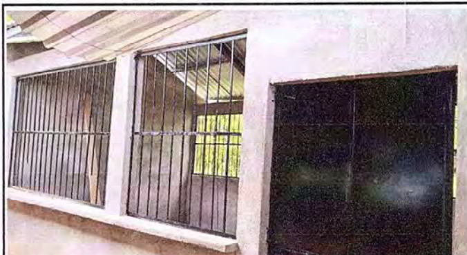
Foto 2: cocina parte de enfrente puerta y balcones instalados.
