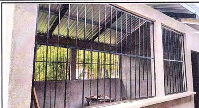
Foto1: Cocina parte de enfrente, trabajo terminado
